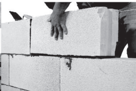
งานก่อผนังอิฐมวลเบา
