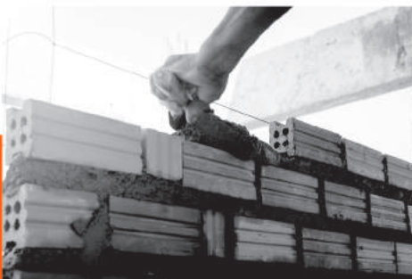
งานก่อผนังอิฐฉาบปูน
